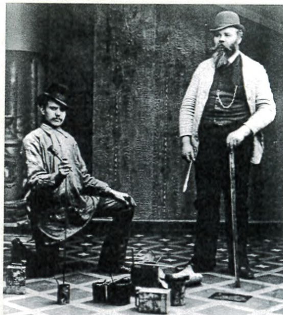
Målarmästaren Erik Johnsson övervakar sin gesäll, i färd med att måla ett golv. Mäster har både klockkedja och plommonstop för att markera sin ställning, men också gesällen har tagit på sig sin hatt: hantverkarna ville gärna visa att de var former än »vanliga arbetare».
