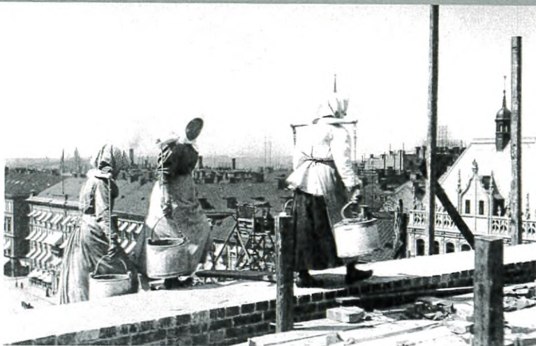
För borgerlighetens kvinnor ansågs allt kroppsarbete okvinnligt. Men i arbetarklassen utförde kvinnorna samtidigt mycket tunga jobb. Ett exempel var »murmäckorna«, som bar tegel och bruk till murarna på byggena – här på operabygget i Stockholm, som blev färdigt 1896.
